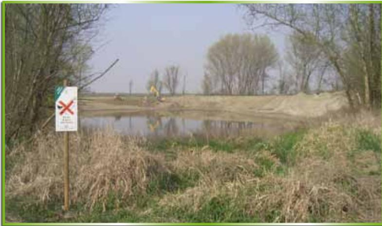
Figura 23. Rinaturalizzazione di una lanca interna attraverso interventi di sagomatura delle sponde (Foto D. Cuizzi - Archivio EURECO)
