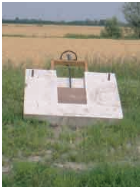
Chiusa di deflusso delle acque del prato irriguo nella rete scolante. A destra, la chiusa in opera. (Foto D. Cuizzi)
