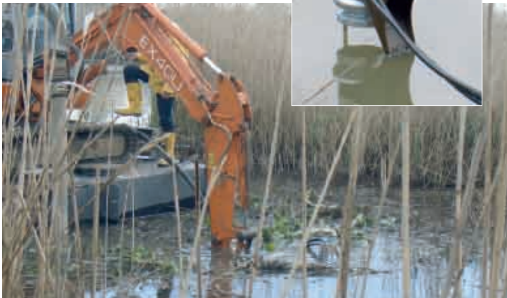
Chiatta attrezzata per lo scavo con miniescavatori, motore e tubo eiettore. A destra: dettaglio della pompa montata su braccio. Sotto: dettaglio del braccio escavatore con pompa al lavoro. (Foto D. Cuizzi) Pagina a fianco: scavo del fiume Busatello. (Foto D. Cuizzi)
