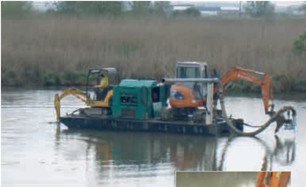
Chiatta attrezzata per lo scavo con miniescavatori, motore e tubo eiettore. A destra: dettaglio della pompa montata su braccio. Sotto: dettaglio del braccio escavatore con pompa al lavoro. (Foto D. Cuizzi) Pagina a fianco: scavo del fiume Busatello. (Foto D. Cuizzi)
